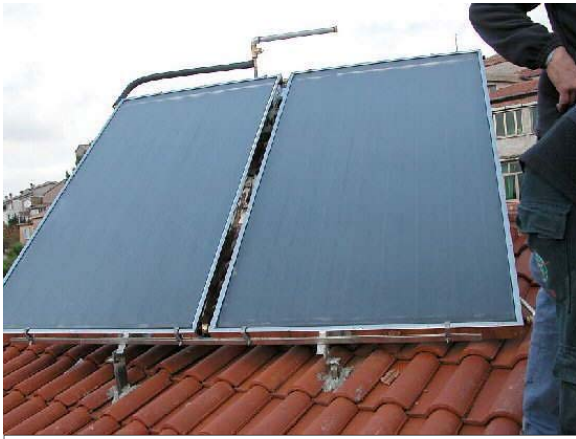
Installazione di pannelli solari per il riscaldamento dell'acqua
